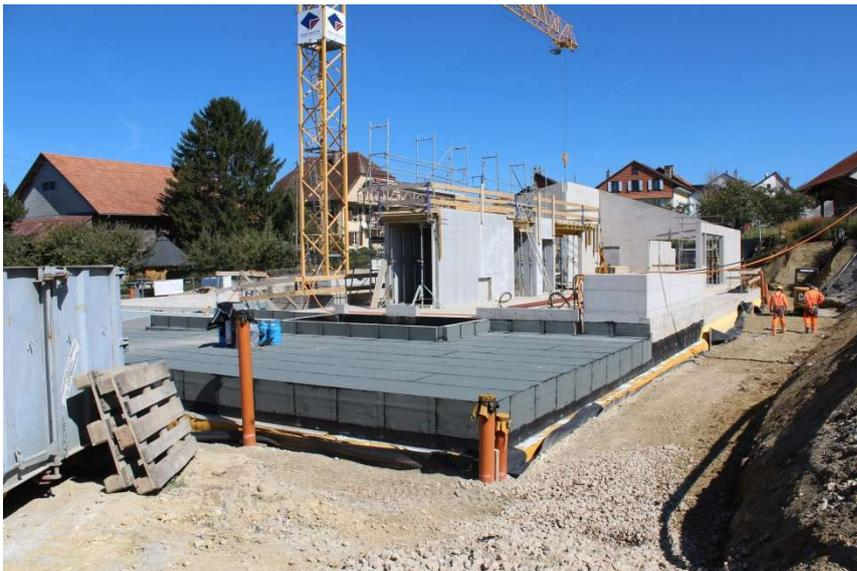
Je rappelle que le chantier avait débuté le 20 février : arrachage des arbres sur la parcelle, creuse et dévoiement des conduites de gaz, électricité, téléphone, eau potable, eaux usées et de surface.
