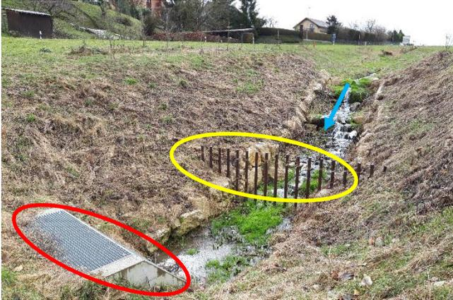
Figure 2 : Vue sur le ruisseau de Pomy à ciel ouvert, côté amont (avaloir en rouge et dégrilleur en jaune).
