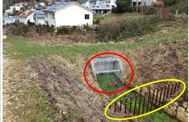
Figure 3 : Vue sur les villas situées en aval des ouvrages (avaloir en rouge et dégrilleur en jaune).
